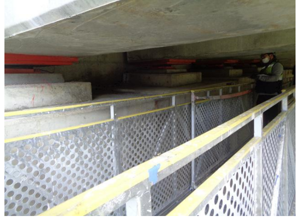
굴절점검차를 이용한 근접조사
