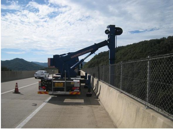
굴절점검차를 이용한 근접조사
